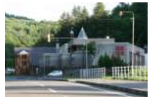
木質バイオマスエネルギーを導入した五味温泉
